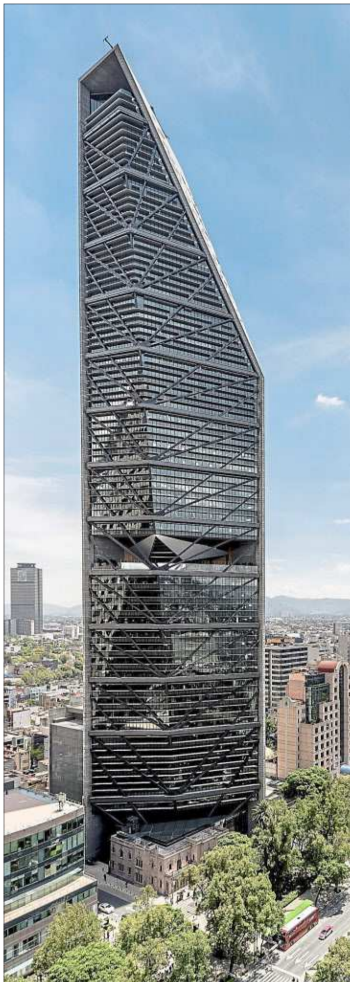
Aus mehr als tausend Hochhäusern hat eine Jury den „Torre Reforma“, einen Büroturm des Architekten L. Benjamín Romano in Mexiko-Stadt, als den besten Wolkenkratzer von allen ausgezeichnet. Der Internationale Hochhauspreis wird seit 2004 alle zwei Jahre von der Stadt Frankfurt gemeinsam mit dem Deutschen Architekturmuseum und der DekaBank vergeben. Foto: Bernouilly/DAM/dpa
